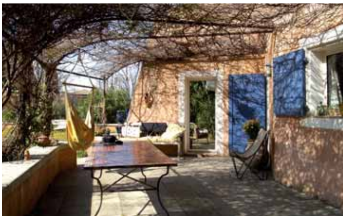
Aménagement d'une pergola
