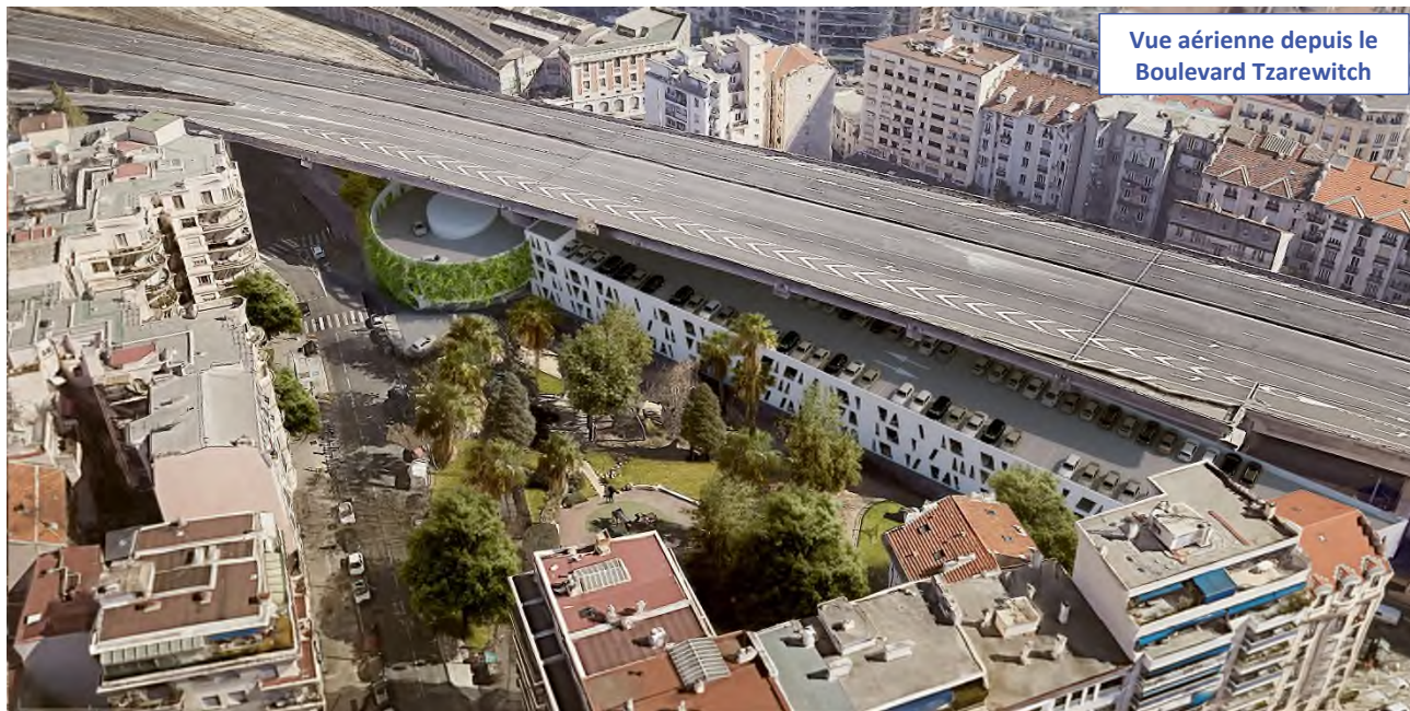
16. Parking Relais Tzarewitch – Vue aérienne oblique depuis le boulevard Tzarewitch (Source : ARTELIA-AFA, septembre 2021)
