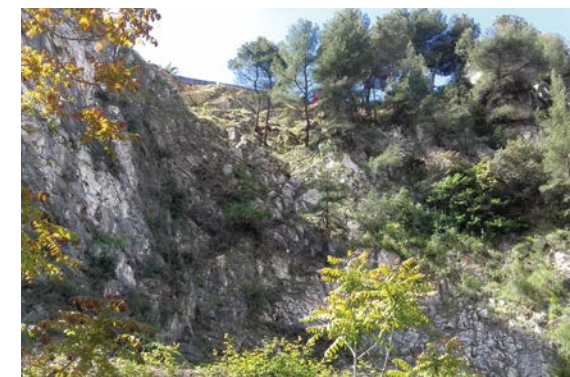
Falaise avant confortement
