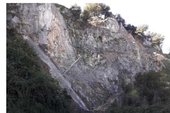
Falaise après confortement
