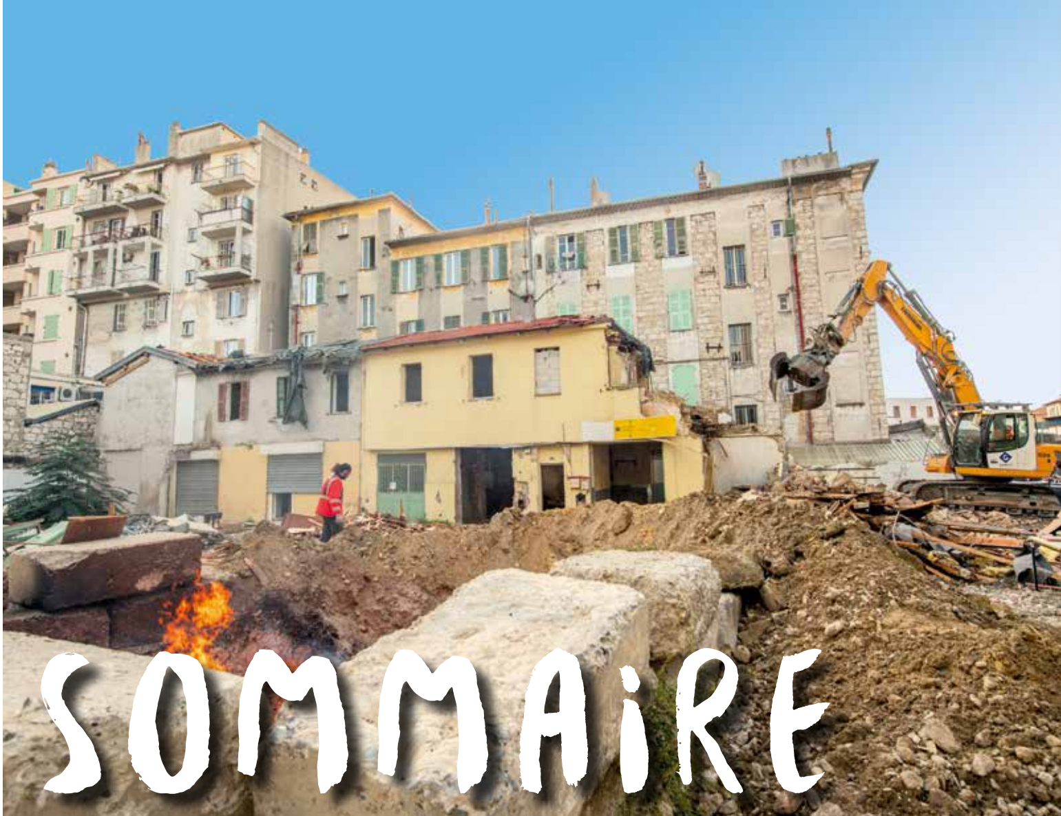
Dernière démolition cour Bensa avec brûlage du bois sur place en octobre dernier (lire p. 4)
