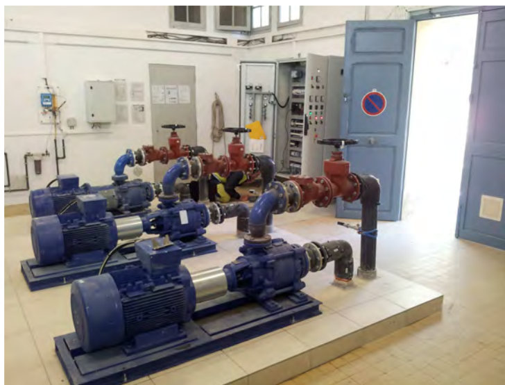
Salle des pompes de l'usine de Camp Ricard, à Saint-Jeannet
