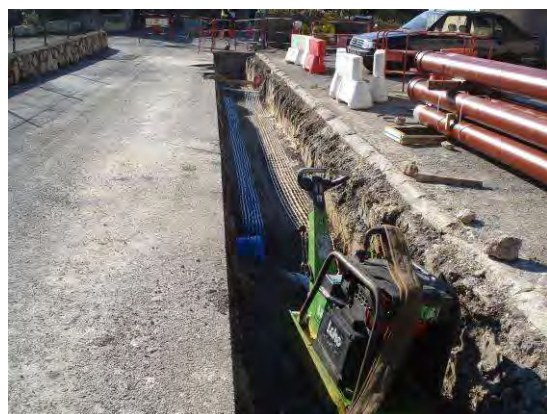
Signalisation des réseaux par grillage avertisseur
