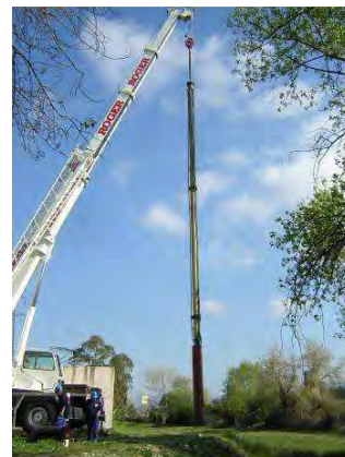
Renouvellement d'une pompe Captage des Pugets -Saint-Laurent- du-Var
