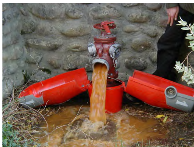
Mise en évidence des eaux rouges sur le réseau d'eau potable, par purge au niveau d'un poteau d'incendie.
