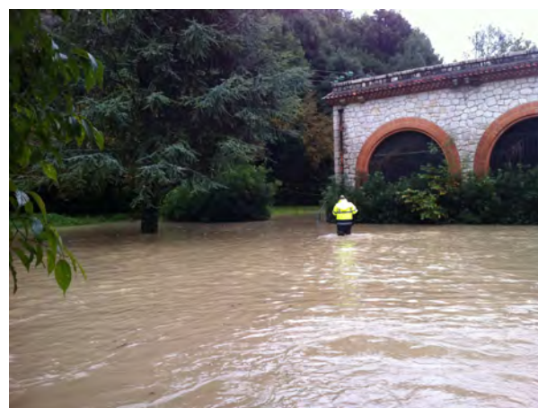
Novembre 2011 : inondation du champ captant de la nappe du Loup à Cagnes-sur-Mer, en
