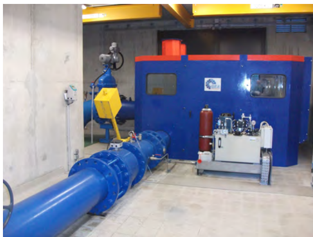
Microturbine du site Passerelle-Paillon à Nice Production d'électricité
