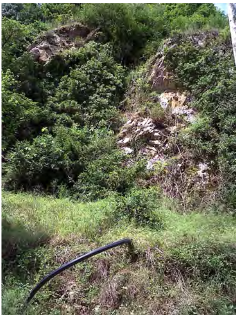
Conduite alimentant en eau le hameau du Rivet à Lantosque, avant les travaux
