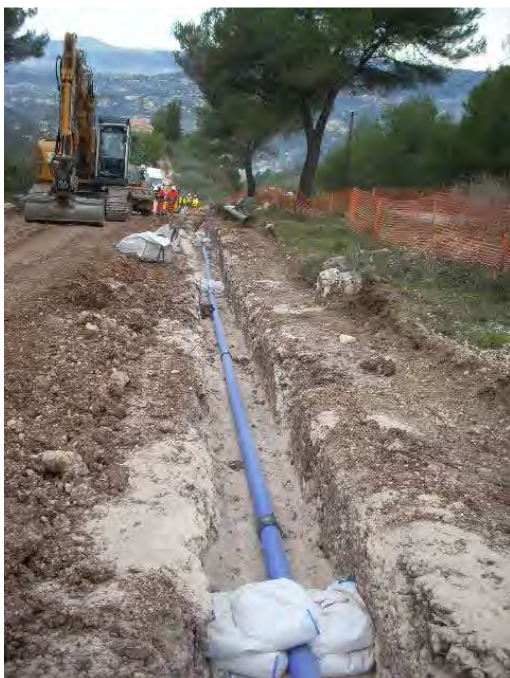
Travaux réalisés dans le parc départemental de la Grande Corniche, avec prise en compte de contraintes environnementales
