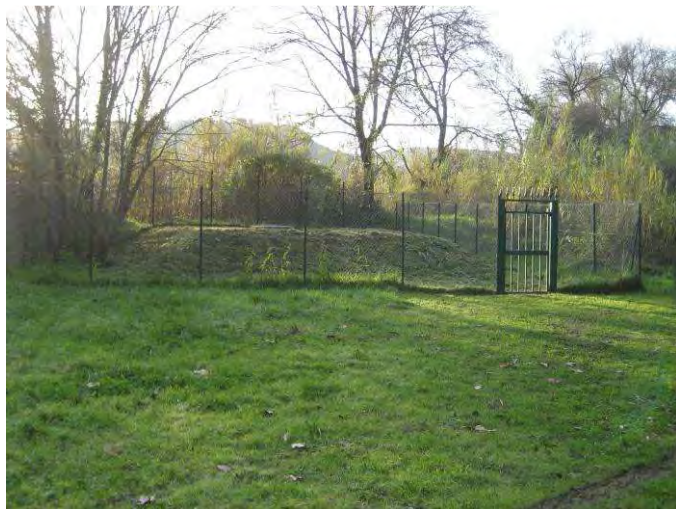
Forage superficiel au champ de captage des Tines (Cagnes-sur-Mer). Périmètre de protection immédiat matérialisé par un grillage.
