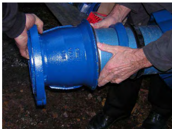
Emboîtement d'une pièce spéciale en fonte verrouillée
