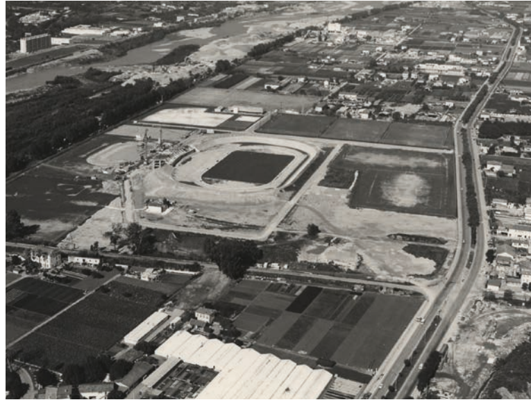
Vue aérienne de la Digue des Français avec le stade (Charles Ehrmann) en construction, 1972 (photographie Ville de Nice, Service des Archives Nice Côte d'Azur).
