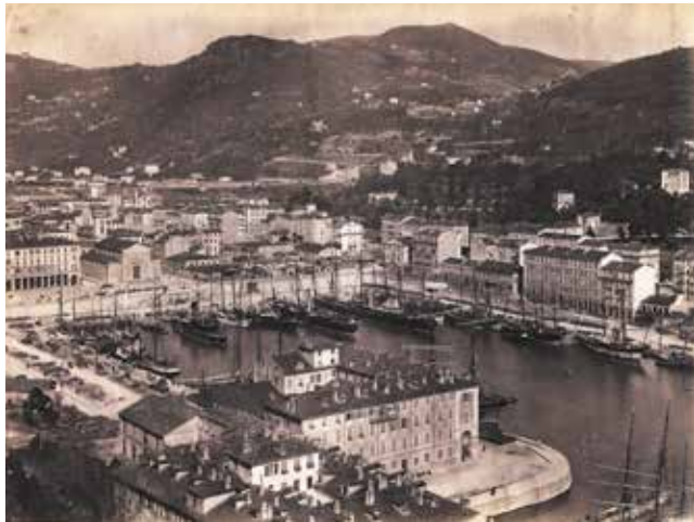
Vue aérienne du port à la fin du 19 e siècle Jean Gilletta © Ville de Nice, Bibliothèque de Cessole
